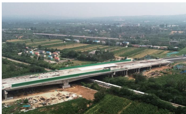
图1 国道234上跨郑西高铁立交航拍
