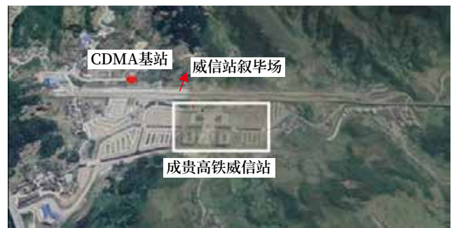
图3 威信站通信设备布局
