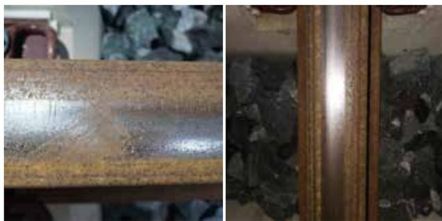
图2 万象站 S1JG 区段轨面锈蚀严重
